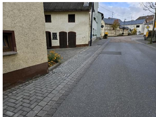
Engstelle durch Gebäudestellung
